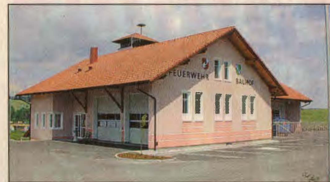
In dem neu errichteten Mehrzweckgebäude sind die Zeugstätte der Freiwilligen Feuerwehr, der Bauhof, sowie ein Jugendraum untergebracht. FOTO: RUNDSCHAU
